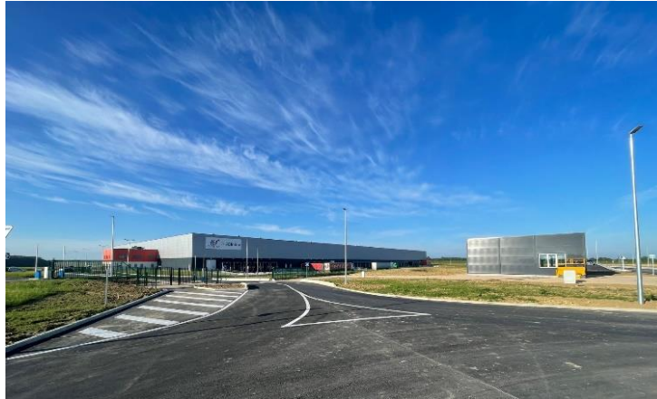
AB InBev site in Neuillé-Pont-Pierre. ©ID Logistics
